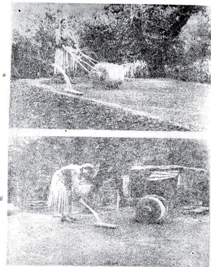
17-чи шәкил. Загатала районунун Сувакил кәнд советинин Гаргчај кәндиндә дахал јашајыш евләри дамларынын үстүнүн бәркидилмәси: а—дијиркә илә; б—дамдөјәнлә.
