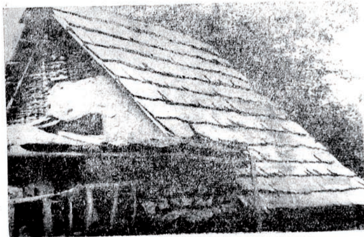
45-чи шәкил. Шәки-Загатала зонасы районларында дам чардагы тахта пар- чалары ил өртүлмүш тикили (1962-чи ил).
