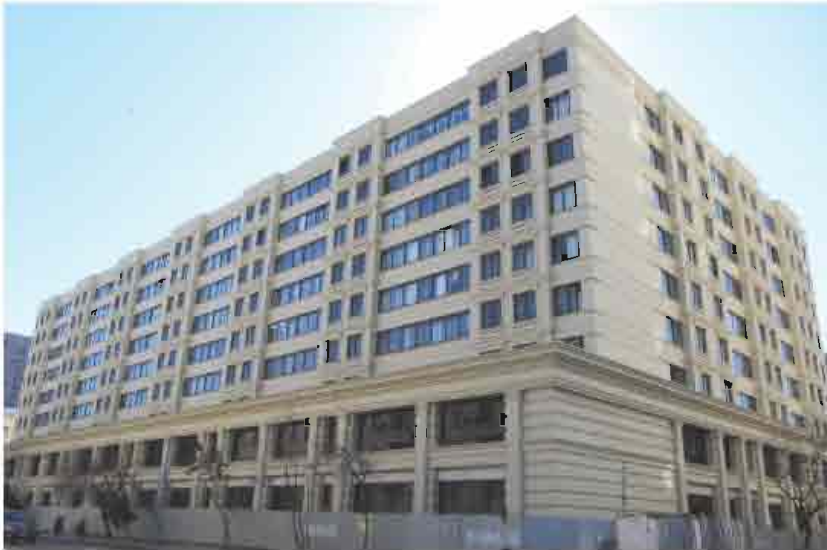
Bakı. 28 May küçəsində "Aerokassa"nın yerləşdiyi yaşayış evinin fasadlarının yenilənməsi
