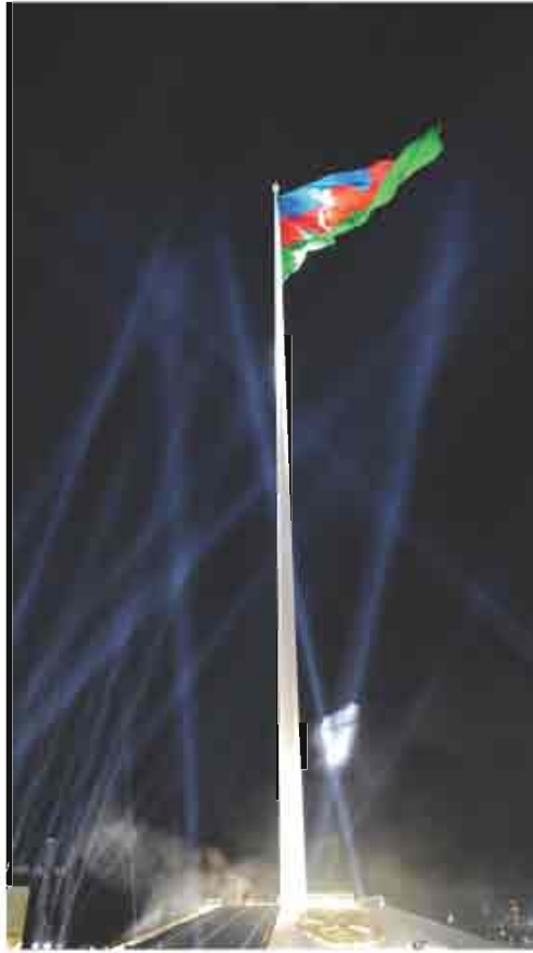
Баку. "Dövlət Bayrağı Meydanı" kompleksi. Müəllif "Trident Support" şirkəti
