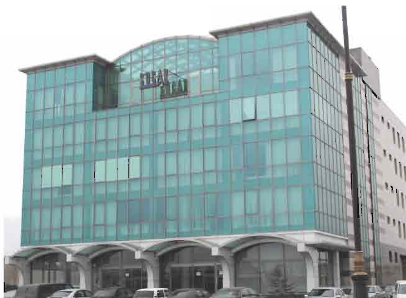
Баку. Babək prospektində Dövlət Neft Şirkəti "Azəriqaz" QSC-nin Layihə-smeta bürosunun və nəqliyyat departamentinin binası. Memar İ.İsbatov
