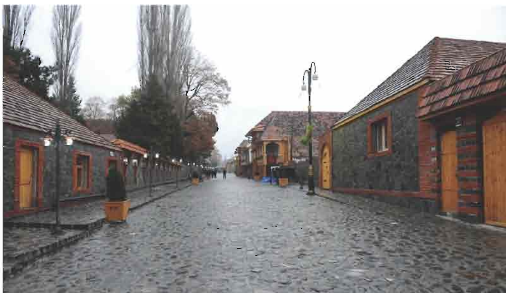
Qax. "İçeribazar" qala kompleksi renovasiya işlərindən sonra. Məmar N.Qasimov
