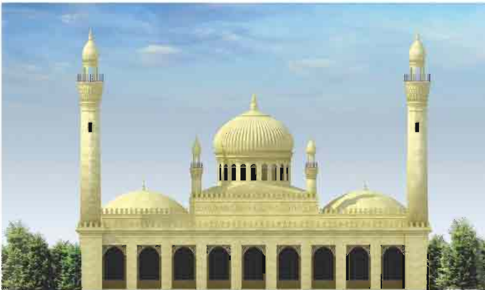
Şamaxı. Memarlar Ziverbəy Əhmədbəyovun və İosif Ploşkonun layihələrlə əsasında Cümə məscidinin bərpası
