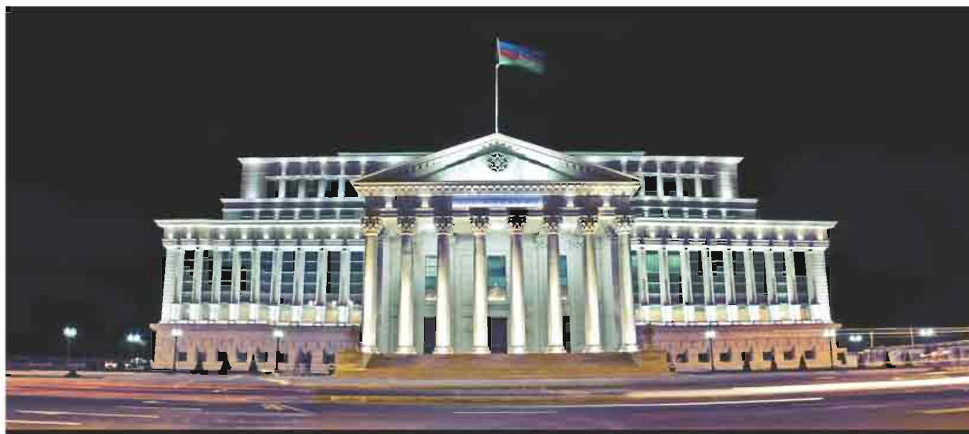
Bakı. Ali Məhkəmə binası. Memar V.Həsənov
