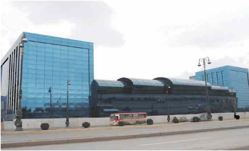
Bakı. Heydər Əliyev prospektində AFFA-nın "Şəfa" idman və Sağlamlıq Mərkəzi yenidənqurma işlərindən sonra. Memar Louz Truzel – "TTMC International" şirkəti
