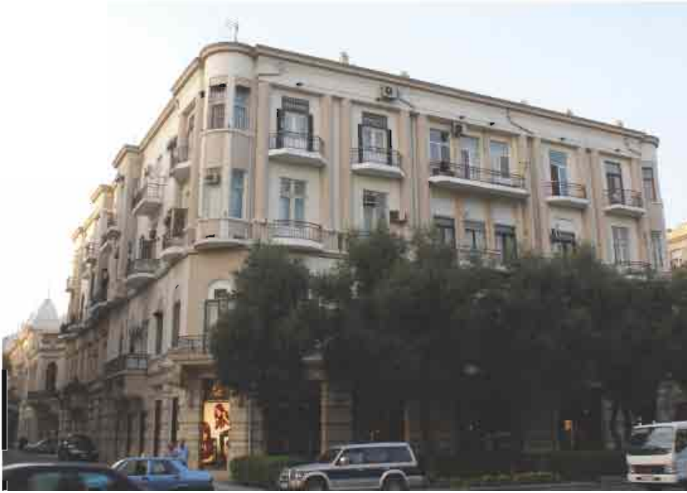
Bakı. Neftçilər prospekti, Hacı Zeynalabdin Tağıyev, Zərifə Əliyeva və Yusif Məmmədəliyev küçələrinin əhatəsində yerləşən yaşayış binası (Neftçilər pr., 117)
