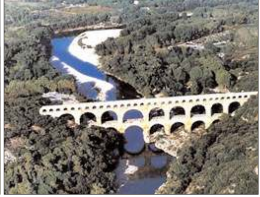
Şəkil 6. Pon-de-Har akveduku.
