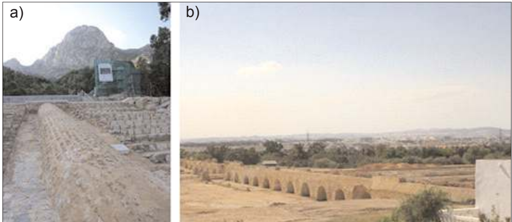
Şəkil 9. a) Atlas dağlarında suyu toplayan keramik boru kəməri; b) Karfagen akvedukunun fraqmentləri.
