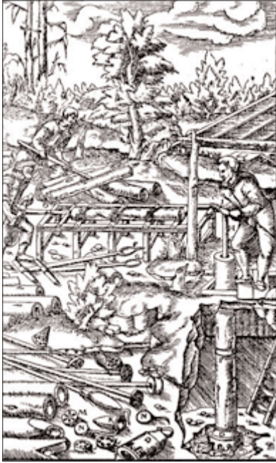
Şəkil 18. Ağac boruların hazırlanması.
