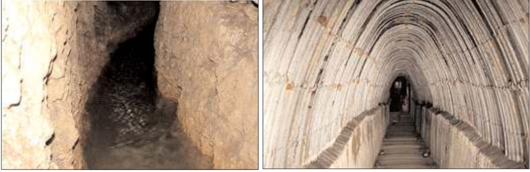
Şəkil 31. Kəhriz dəhlizinin yer altında görünüşü.
