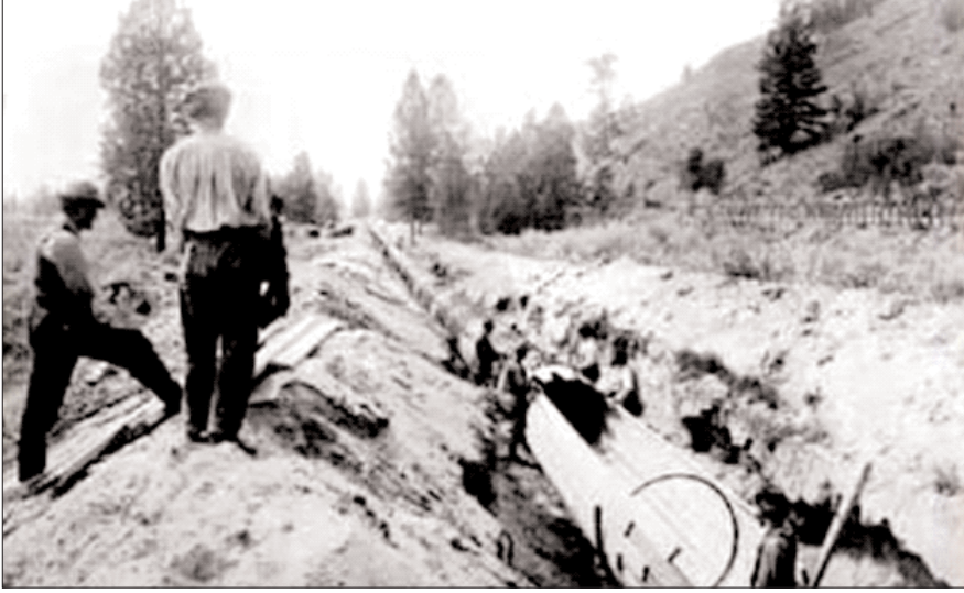
Şəkil 20. 48 dyümlük ağac boruların Fruitlands İrrigation and Power Co.kompaniyasının mütəxəssisləri tərəfindən yığılması, 1910-cu il.
