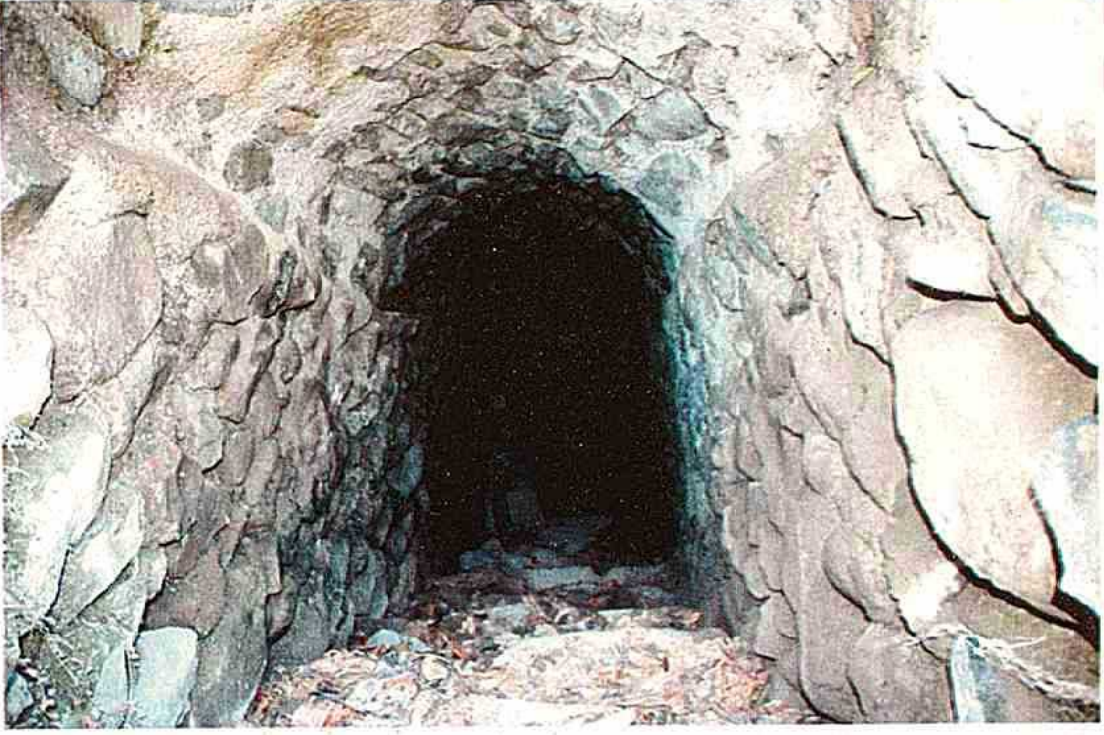
Şəkil 36. Yuxarı Əylis kəndində çay daşından inşa olunmuş qırxpillə
