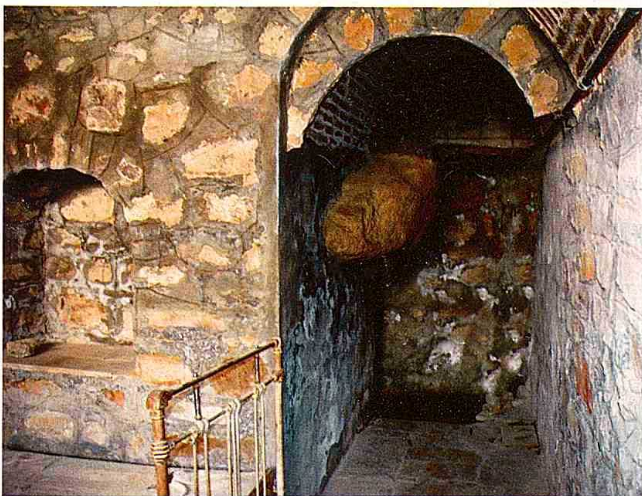
Şəkil 45. Ordubad şəhərində "Məmməd Sadıq" kəhrizində qırxpillənin daxili görünüşü
