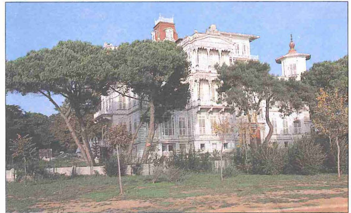
Mâbeyinci Râgıb Paşa Köşkü - Caddebostan / İstanbul
