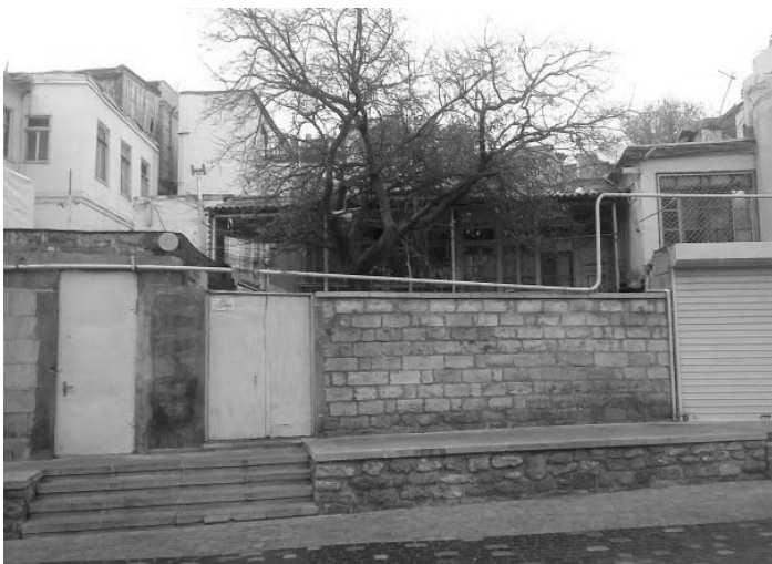
Fasadın A.Zeynalı küçəsindən görünüşü (2016)
