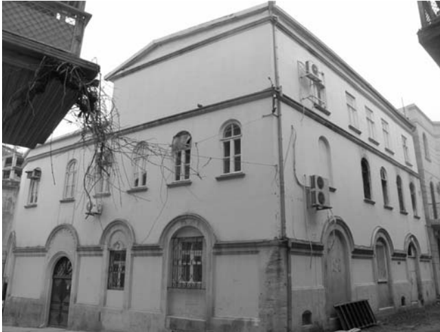
Binanın şimal-şərq və şimal-qərb fasadı
