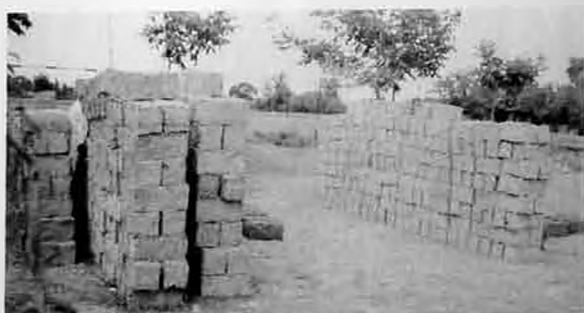
İnşaat materialı: 1-çiy kərpicin qurudulması; 2- kərpic xəyəi.
