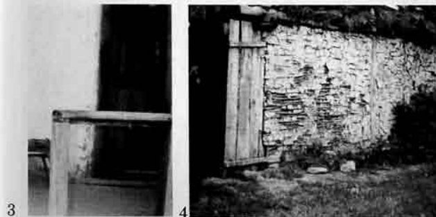
Yaşayış evi və təsərrüfat tikilisi: 1-ikimərtəbəli ev; 2- altıaçıq; 3-4-çubuqçitmə ev və onun qapısı.
