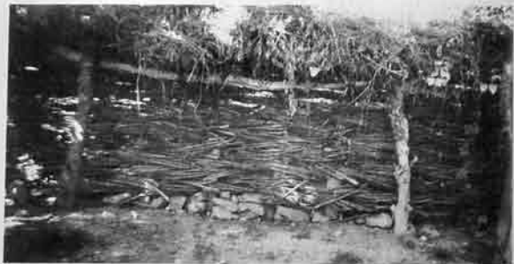
Hasarlar: 1-2- cəbir (daş hörgülü) hasar; 3- bajqunlu çəpərə hasar.
